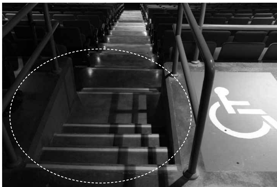
圖 5 本院履勘照片 3：本案無障礙席位比前一排（一般觀眾席）墊高 6 階總計 72 公分。
