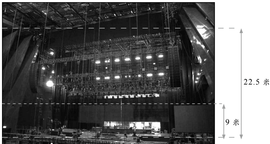
圖 8 本院履勘照片 6：本案舞臺高度（黃色虛線為無障礙席視野；紅色虛線為淨高度 22.5 米）。
